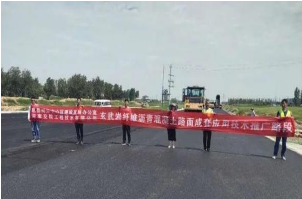
图 3-2 玄武岩纤维在高速公路建设中的应用现场
